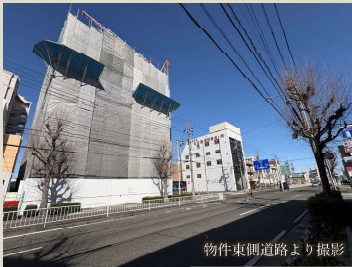
物件東側道路より撮影
